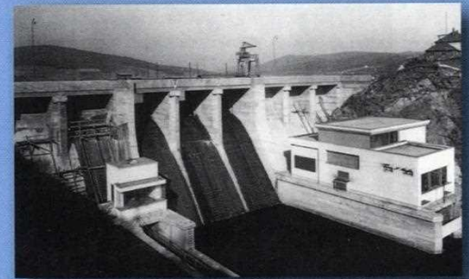
Hráz Knížičské přehrady po dokončení (Archiv města Brna)
