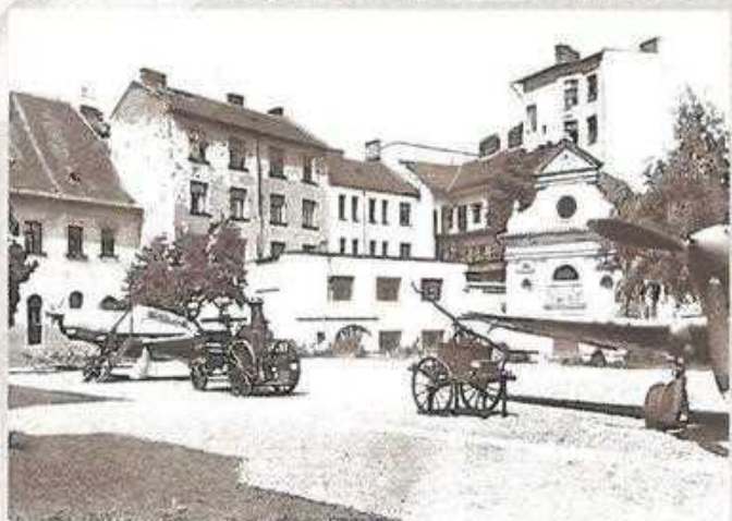
Úprava velkého nádvoří
