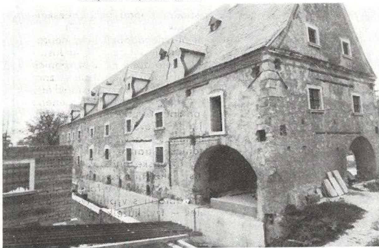
Návodní strana mlýna s rekonstrukcí vodních žlabů pro kola na spodní dopad vody, 1981 Foto: R. Pavlíček
