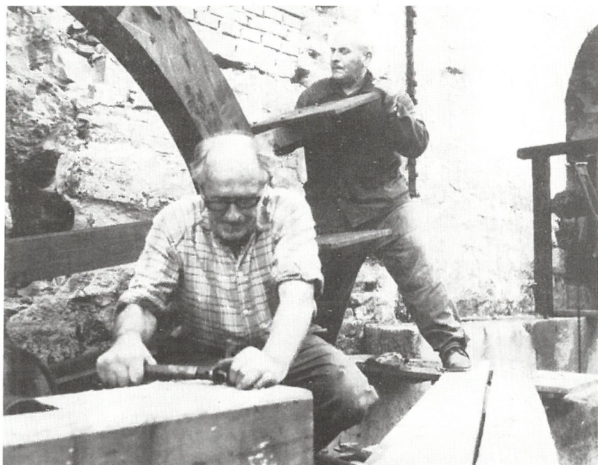
Tesaři JZD Mír v Koryčanech při montáži vodních kol, 1982 Foto: V. Sedlák
